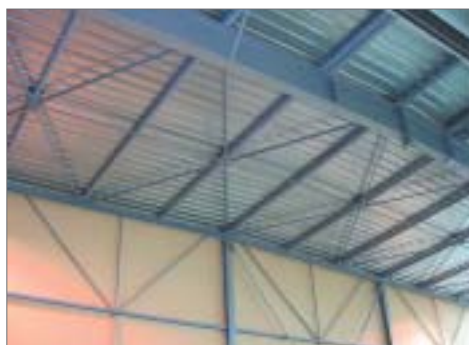
Structures métalliques plafond salle omnisports
